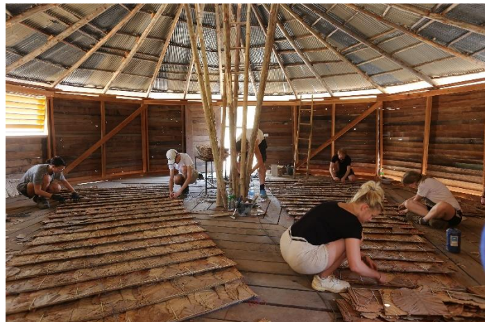
Studierende bei den Innenarbeiten Foto: Rainer Hirth
