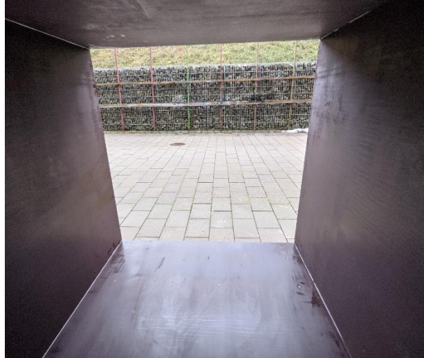
Bild 4: Innenansicht des gedämmten solarCUBES
